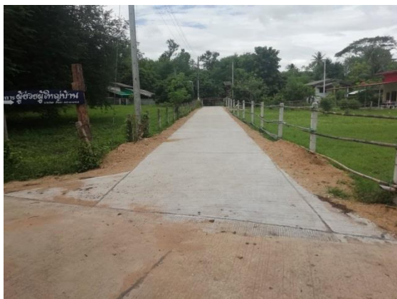
โครงการก่อสร้างถนน คสล. ม.๘ บ้านนายชะลอ อินลา
