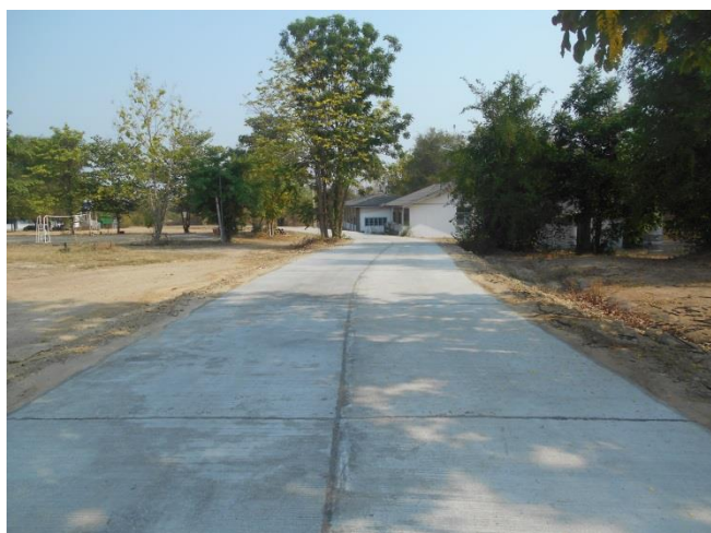
โครงการก่อสร้างถนน คสล ภายใน อบต.แม่เว หมู่ ๘
